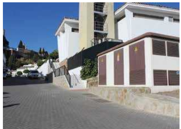
➤ Vista del tramo de calle Rosaleda donde se ha actuado.
