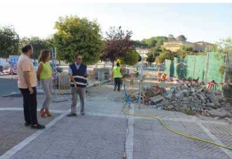
➤ La alcaldesa acompañada del concejal-delegado de Urbanismo visita el desarrollo de las obras del PROFEA en avenida Manuel de Falla.
