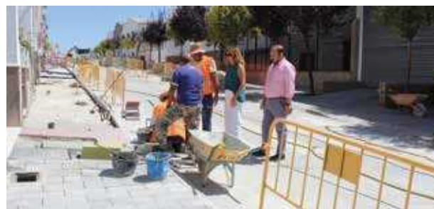
➤ La alcaldesa visita la marcha de las obras en calle Panamá, donde se sustituye el acerado existente e incluye una nueva red de abastecimiento, alumbrado y pasos peatonales.
