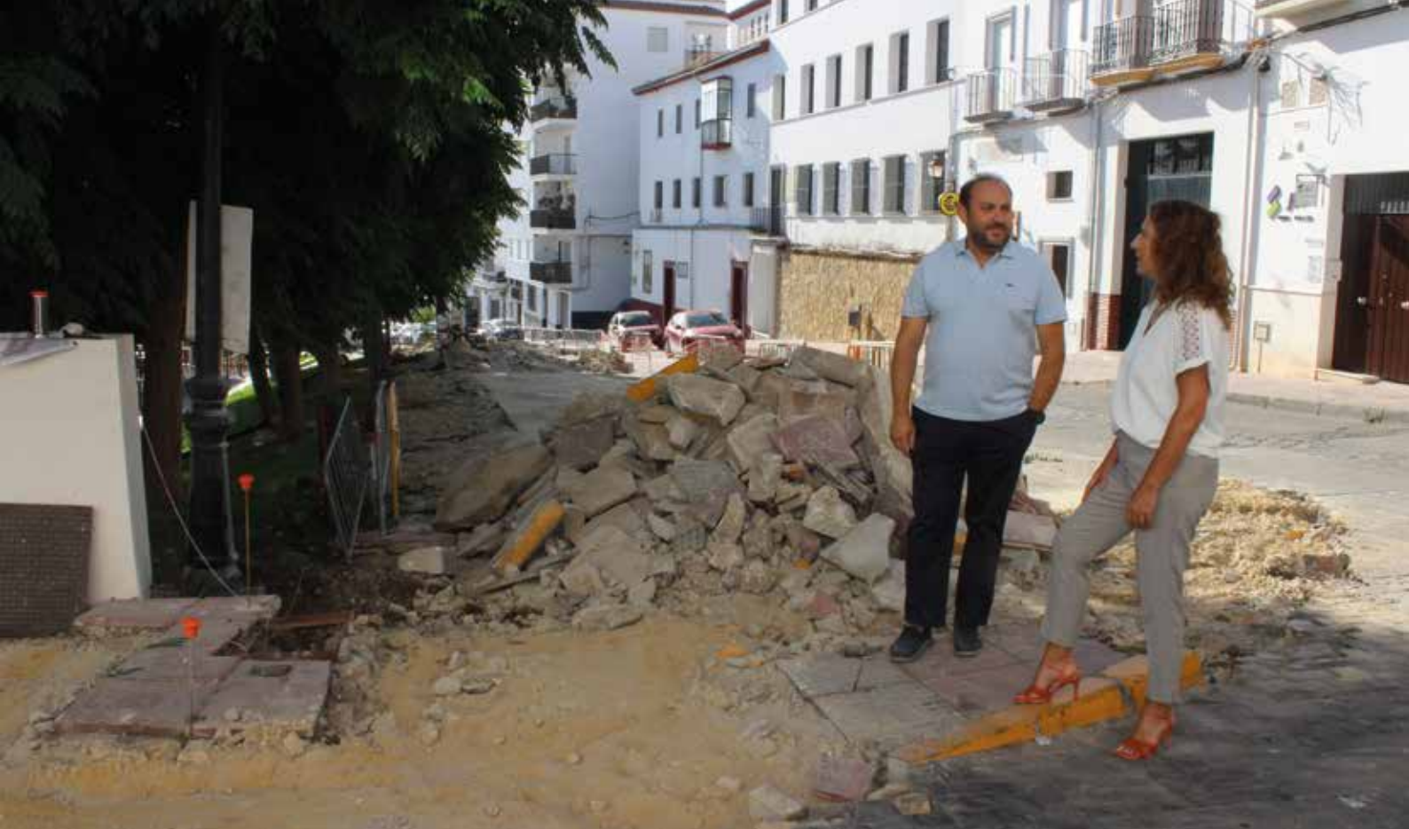
➤ Fotografía tomada al inicio de las obras de regeneración del itinerario peatonal en calle Mercado.
