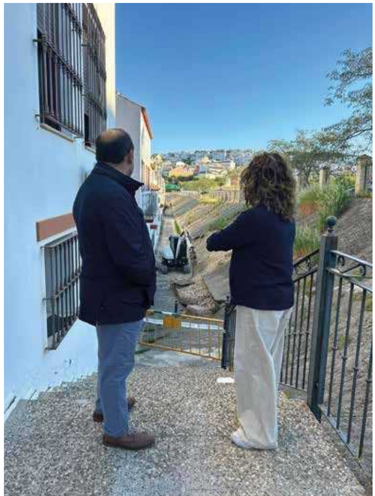
➤ Inicio de la obra de emergencia a finales del mes de abril.
