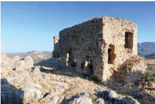
➤ Restos de edificio en el interior del castillo.
