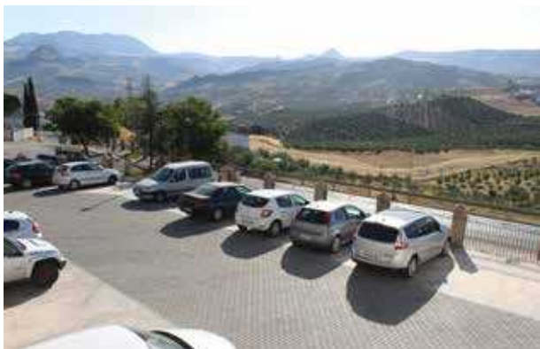
➤ Vista del nuevo aparcamiento en calle Rosaleda.
