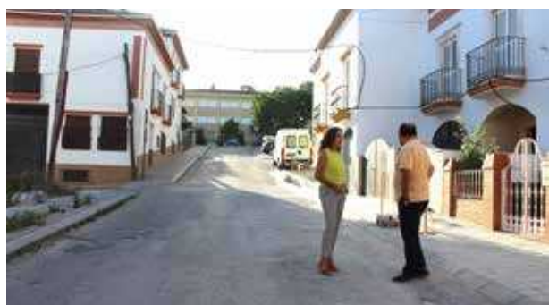
➤ La alcaldesa y el concejal-delegado de Urbanismo visitan la actuación en calle Puerto Caridad, donde se ha sustituido el acerado existente y se ha incluido una nueva red de abastecimiento y alumbrado público.
