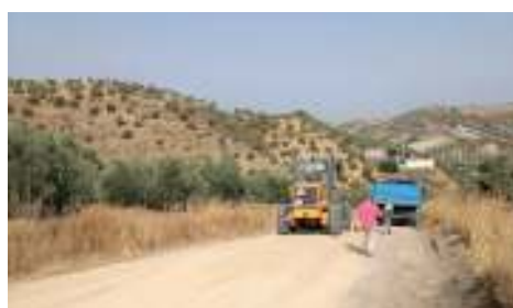
Obras de emergencia en el Camino Rural Colada de Morón.
