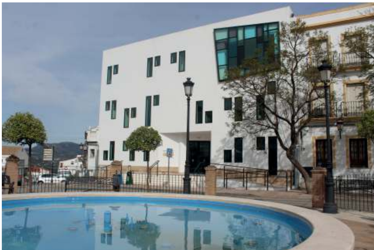
Fachada principal de la nueva Biblioteca Pública Municipal en la Plaza de la Concordia.
