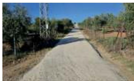
El Ayuntamiento de Olvera ha actuado en el camino Gastalarreja con una inversión de 14.239,50 euros.
