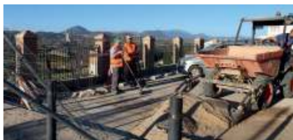
Actuación en el mirador de calle Vereda Ancha.
