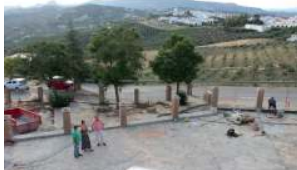
Obras en el nuevo aparcamiento disuasorio de calle Rosaleda.
