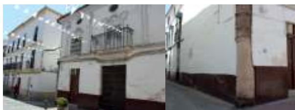
El edificio ‘Rancho Grande’ de la calle Llana, 11.
