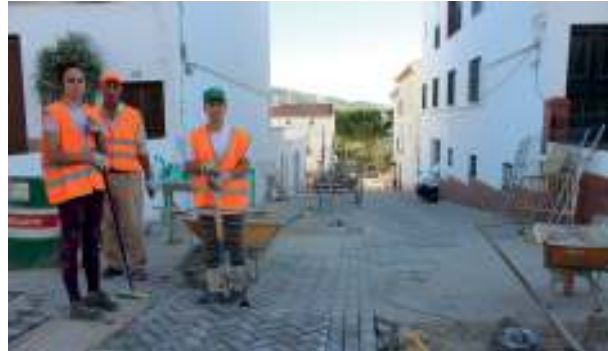
En la calle bajada a Plaza de Europa se ha actuado repavimentando la calle en modo plataforma unica con preferencia peatonal.
