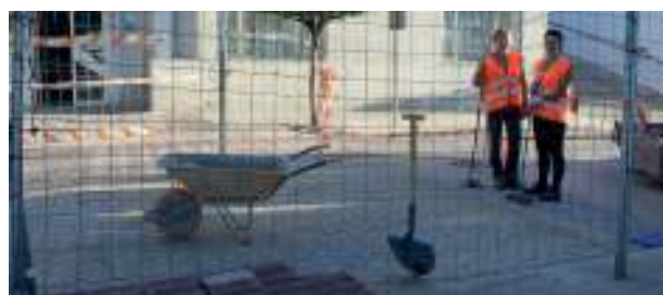
Paso sobreelevado en Vereda Ancha.
